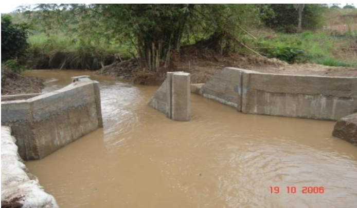
Construction d'un micro barrage hydro-agricole de Nzundu, réalisé par l'AVOLAR et financé par la FAO RDC en 2006.
