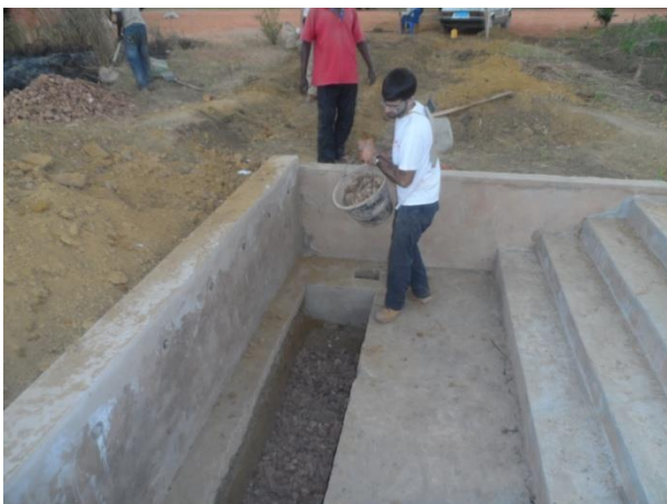
Construction d'une borne fontaine dans le site de l'AVOLAR à Boko.
