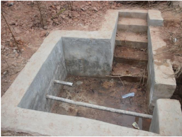
Aménagement d'une source d'eau potable à Mbemba
