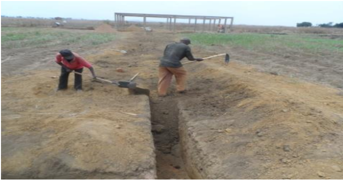
Terrassement des tuyaux du réservoir jusqu'à la borne fontaine dans le site de l'AVOLAR à Boko.
