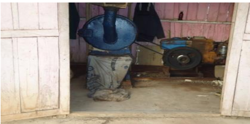
Mise en place d'une meunerie pour la fabrication des aliments de bétail pour l'AVOLAR.
